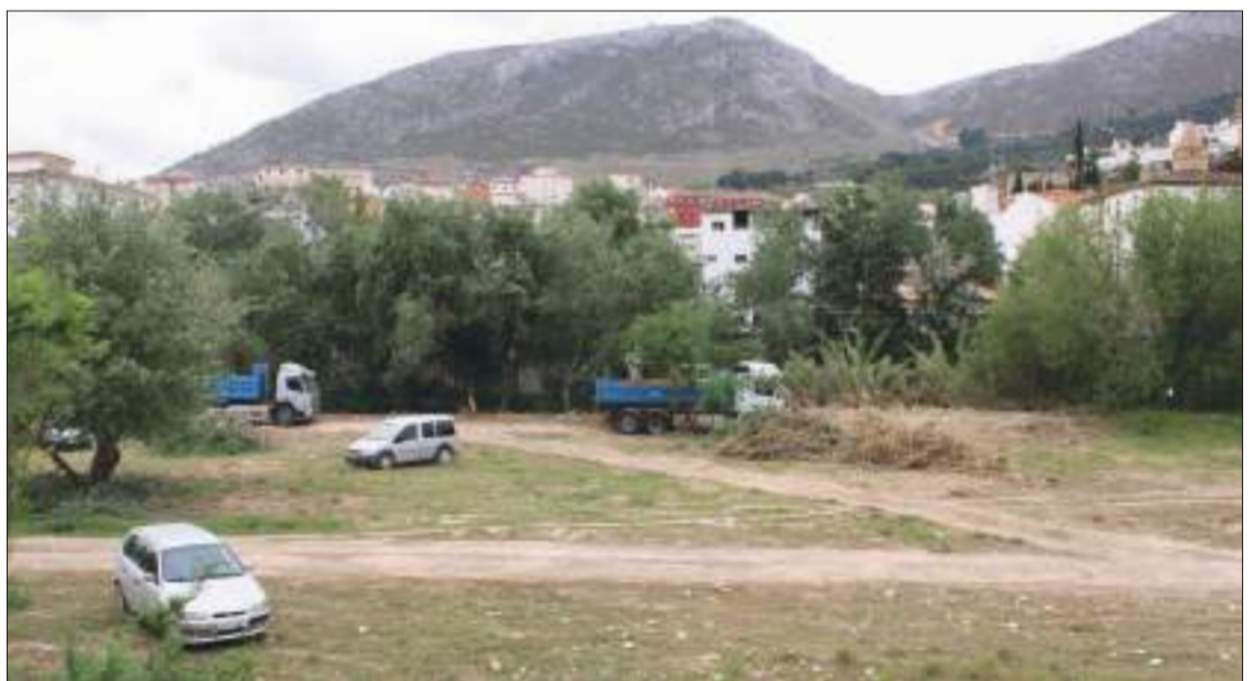
(Arriba) Maquinaria pesada trabaja en un tramo de la carretera de Ventorros de San José; (en el centro) obreros construyen el muro perimetral del manantial del Frontil; (abajo) trabajos de retirada de la berma aladaña al río Genil. FOTO: C. MOLINA
