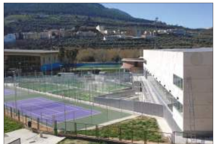
Aspecto actual que presenta el Centro Deportivo de Loja. FOTO: CALMA
