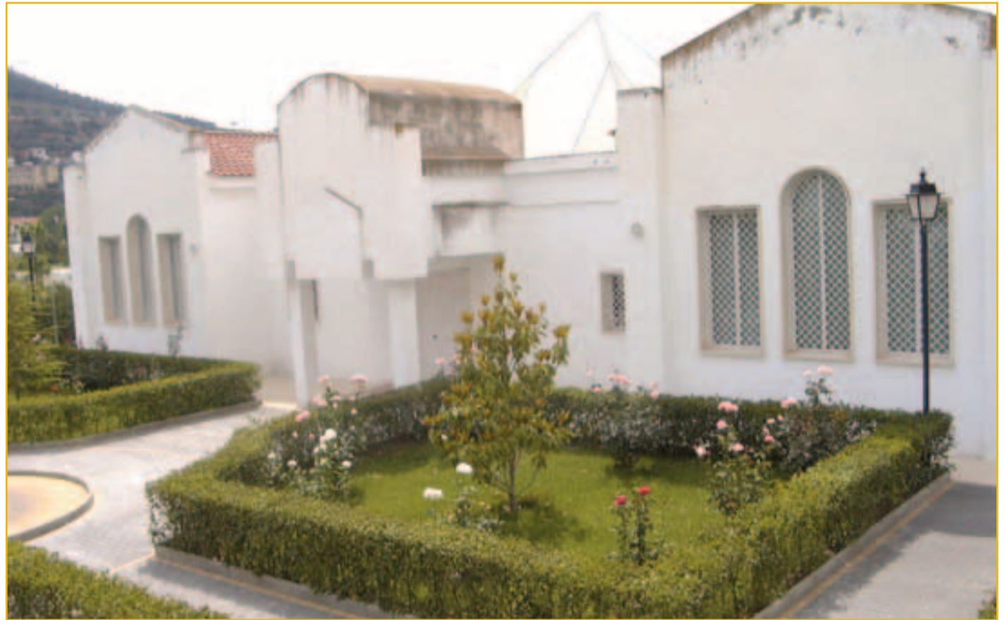
Actuales instalaciones del Patronato de San Ramón y San Fernando, situadas en la calle Hermanas Mercedarias de la Caridad. FOTO: EL CORTO
