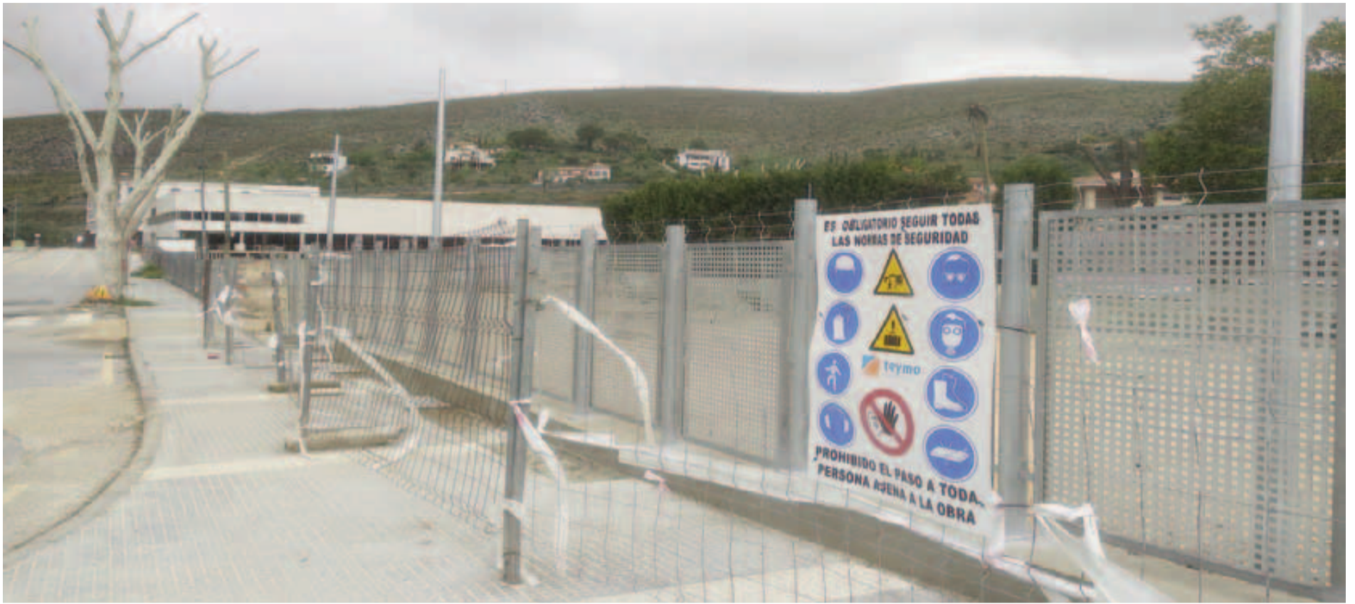
Estado de las obras en el Centro Deportivo Urbano de Loja en donde ya se ha comenzado a delimitar el espacio exterior del mismo. FOTO: CARLOS MOLINA
