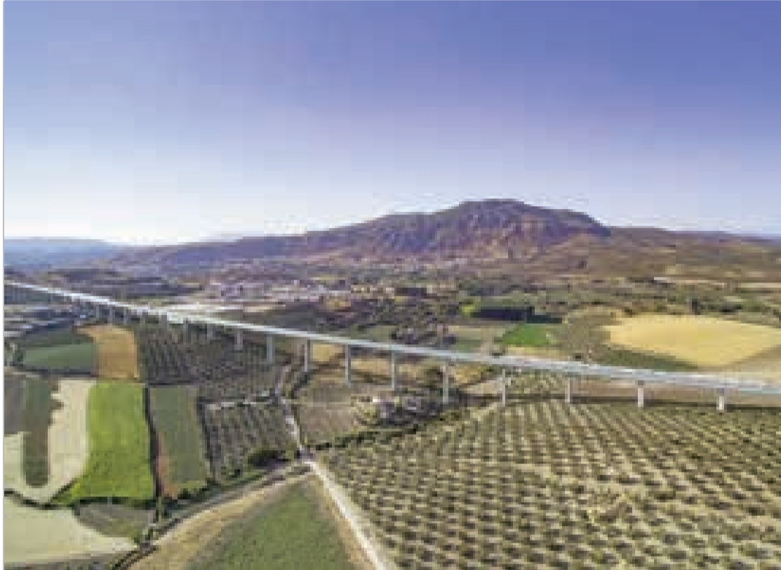
Viaducto de Salar de la Variante de Loja en su tramo del Valle del Genil. FOTO: ADIF
