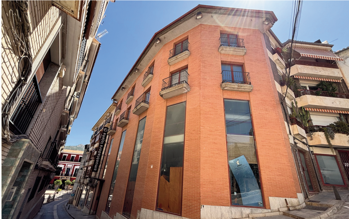
Edificio de la antigua Amuebladora Lojeña, donde irá la futura biblioteca 'Juan de Loxa'. FOTO: ALBERTO A. MATAS
