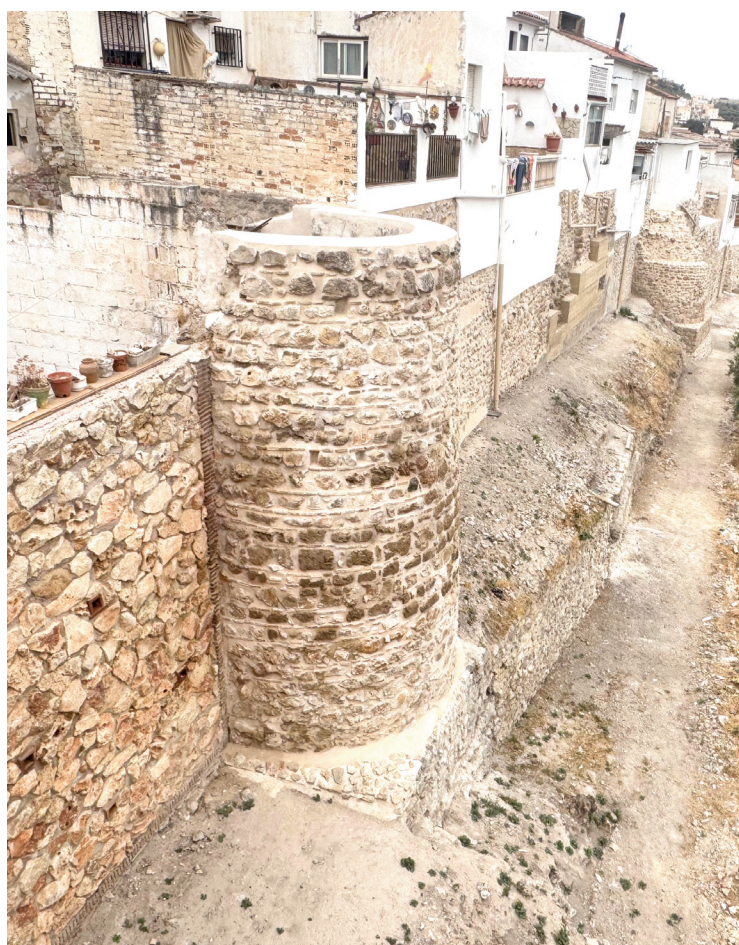
Resultado de la intervención en una de las torres de la muralla. FOTO: C. M.
