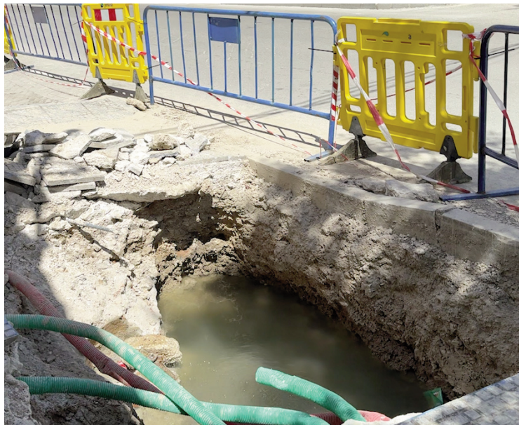
Se ha actuado en grandes socavones provocados por roturas y lluvias. E.C.
