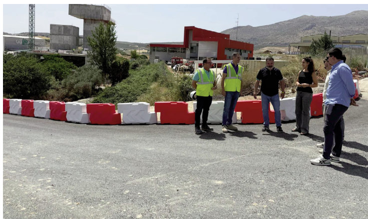
Visita de los concejales a las obras del nuevo vial en el Polígono Manzanil II. R. ALCAIDE
