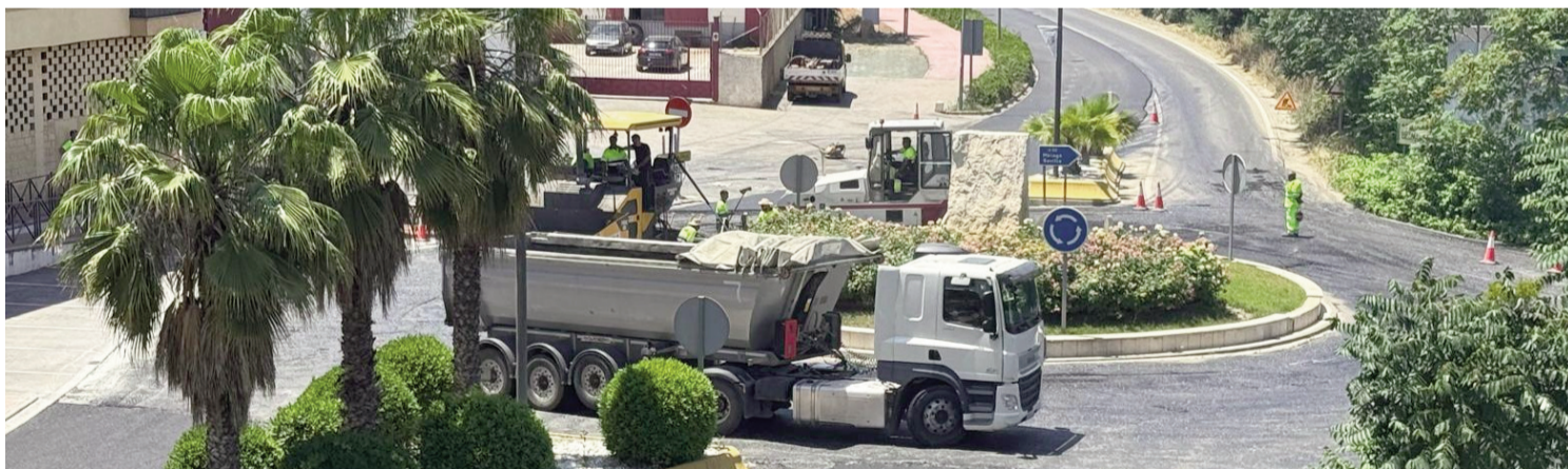
Momento del asfaltado de la rotonda de acceso a Loja al oeste de la zona del Taxi con la intersección de acceso al vial de unión con Llano Piña. FOTO: C. MOLINA
