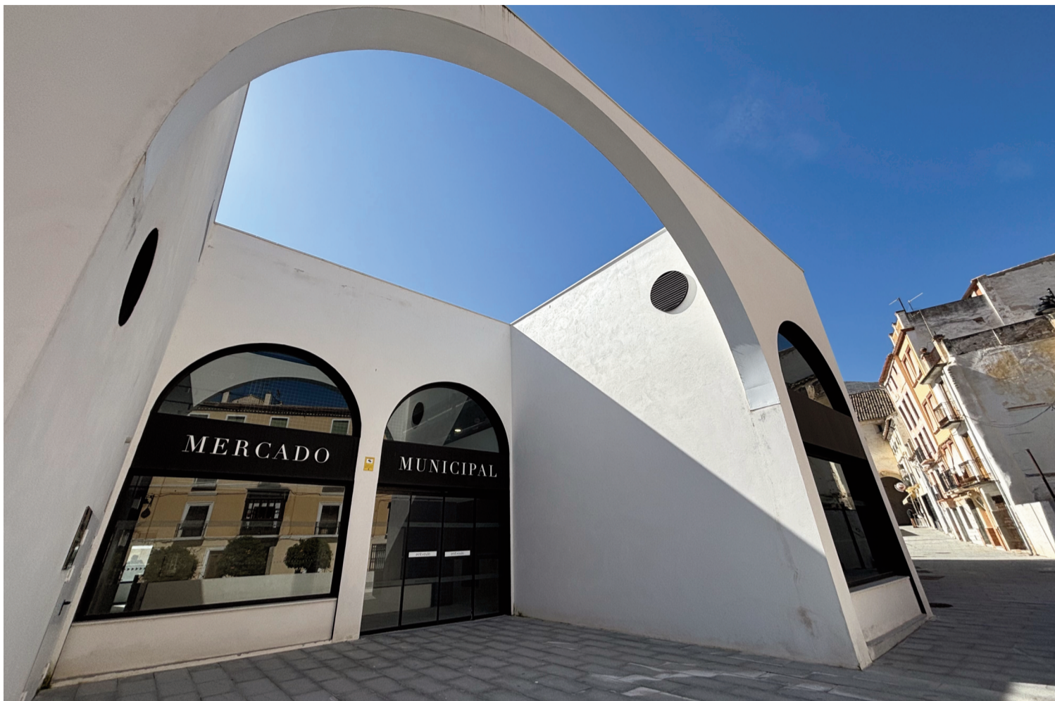
Arriba, una de las entradas del nuevo mercado municipal, la que da a la calle Caridad. Abajo, los dos puestos destinados a hostelería con vistas a la plaza de El Pósito. FOTOS: A. MATAS.
