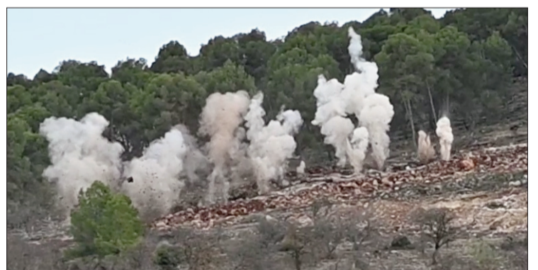
Momento de las primeras voladuras superficiales en la Sierra de Loja. A. MATAS
