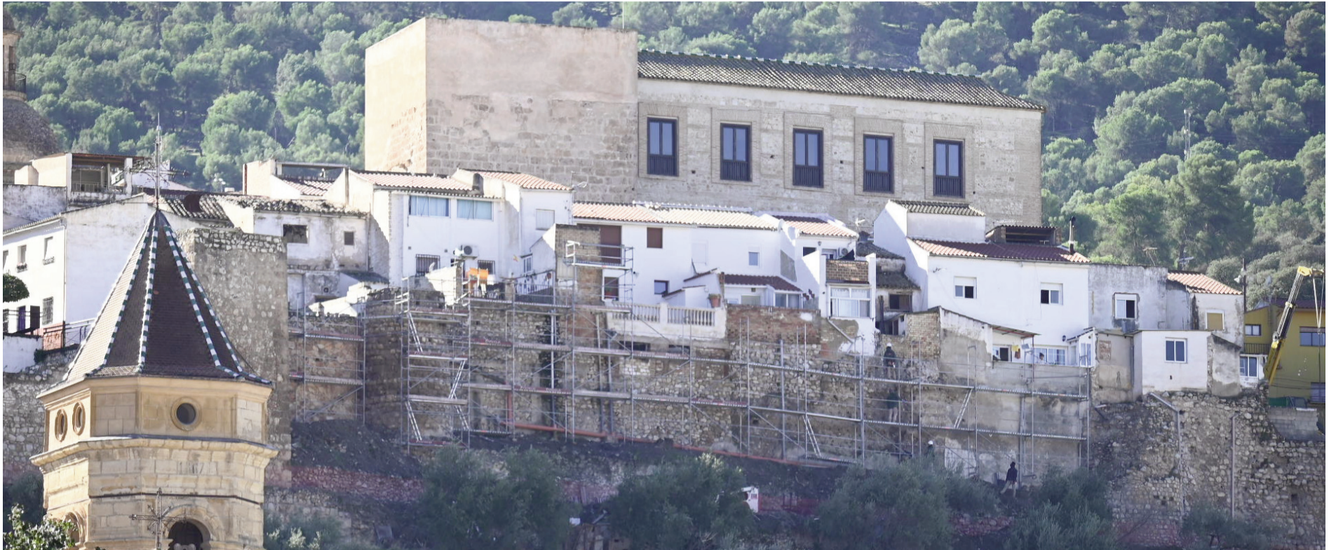
Visión general de los trabajos en la muralla norte de la Alcazaba donde se observa la limpieza de vegetación de zonas aledañas y la colocación de los andamios que permitirán la restauración. FOTO: CARLOS MOLINA
