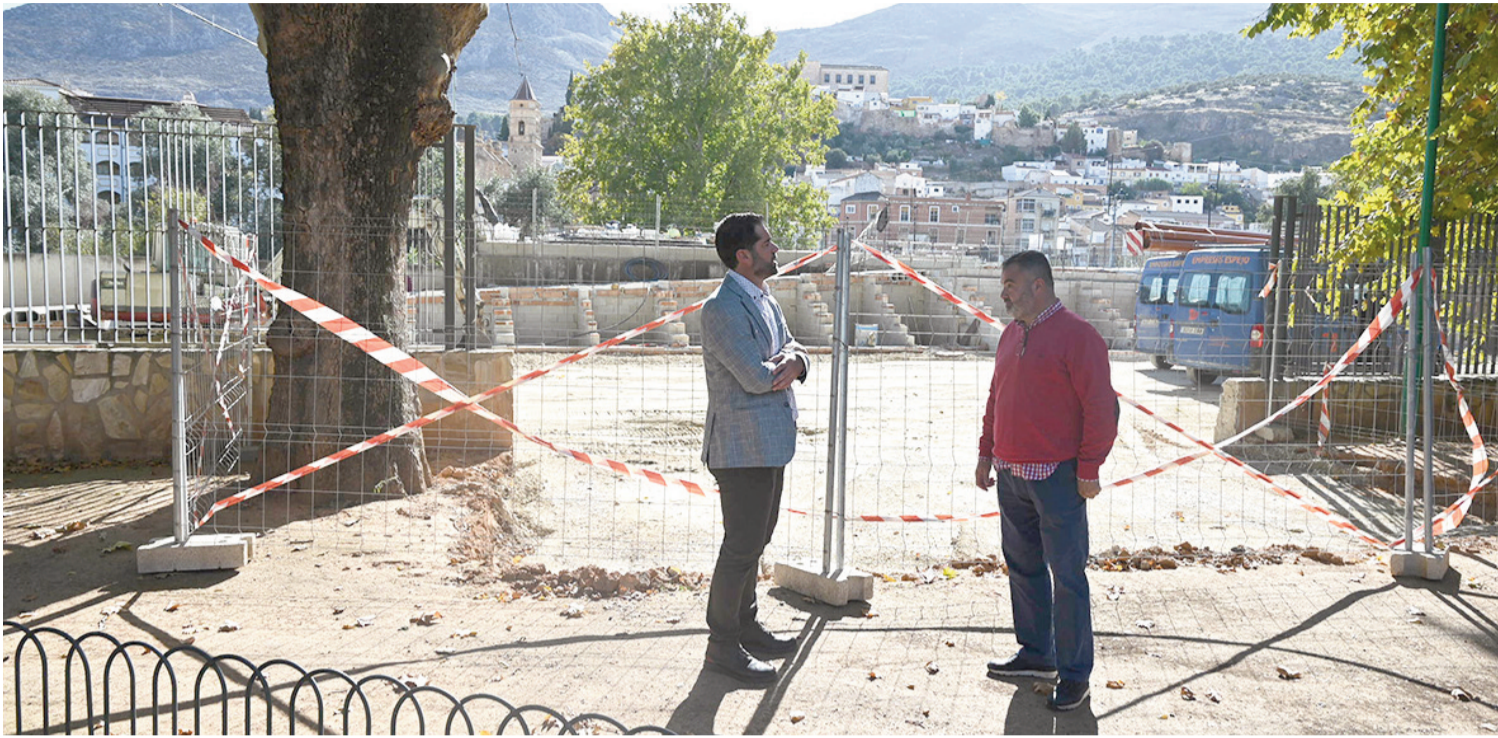
El alcalde y el concejal de Urbanismo en una visita a las obras. FOTO: CARLOS MOLINA
