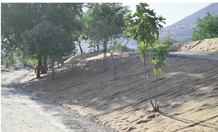
Manta orgánica de protección en una de las escolleras cercanas al Puente Aliatar.
