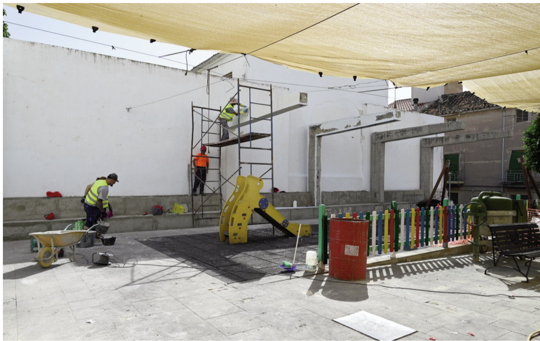
Obras de reforma de la plaza del Carnaval del barrio Alto lojeño a cargo del PFEA. FOTO: CALMA
