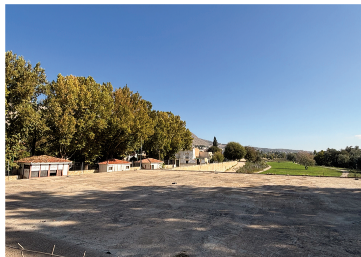
Plaza anexa al puente Gran Capitán en la que se va a actuar. FOTO: A. MATAS
