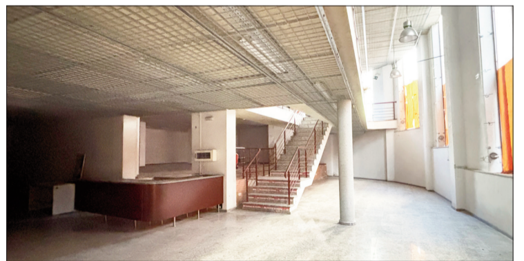
Zona de acceso al edificio de la futura biblioteca municipal. A. MATAS.
