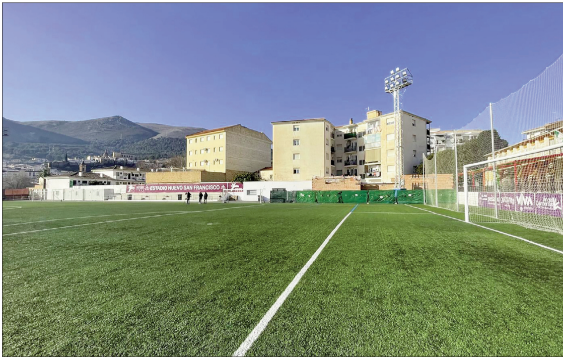
Al fondo a la dcha, la obra de los tres vestuarios que se construyen en el campo de fútbol San Francisco. FOTO: CALMA
