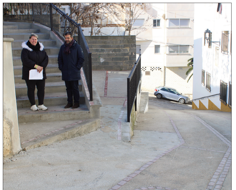
La concejala y el alcalde supervisan las obras realizadas en la calle. FOTO: C. M.
