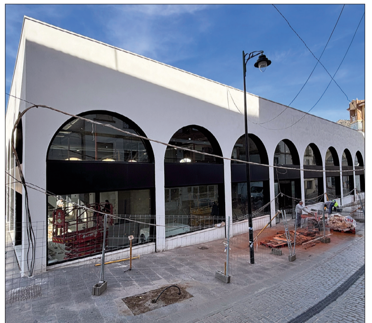
Imagen exterior que ofrece el nuevo mercado municipal. FOTO: A. M.
