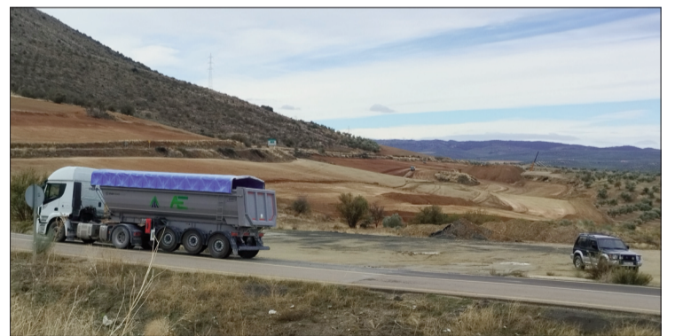
Obras en las inmediaciones de la futura Estación de AVE del municipio. EL CORTO.
