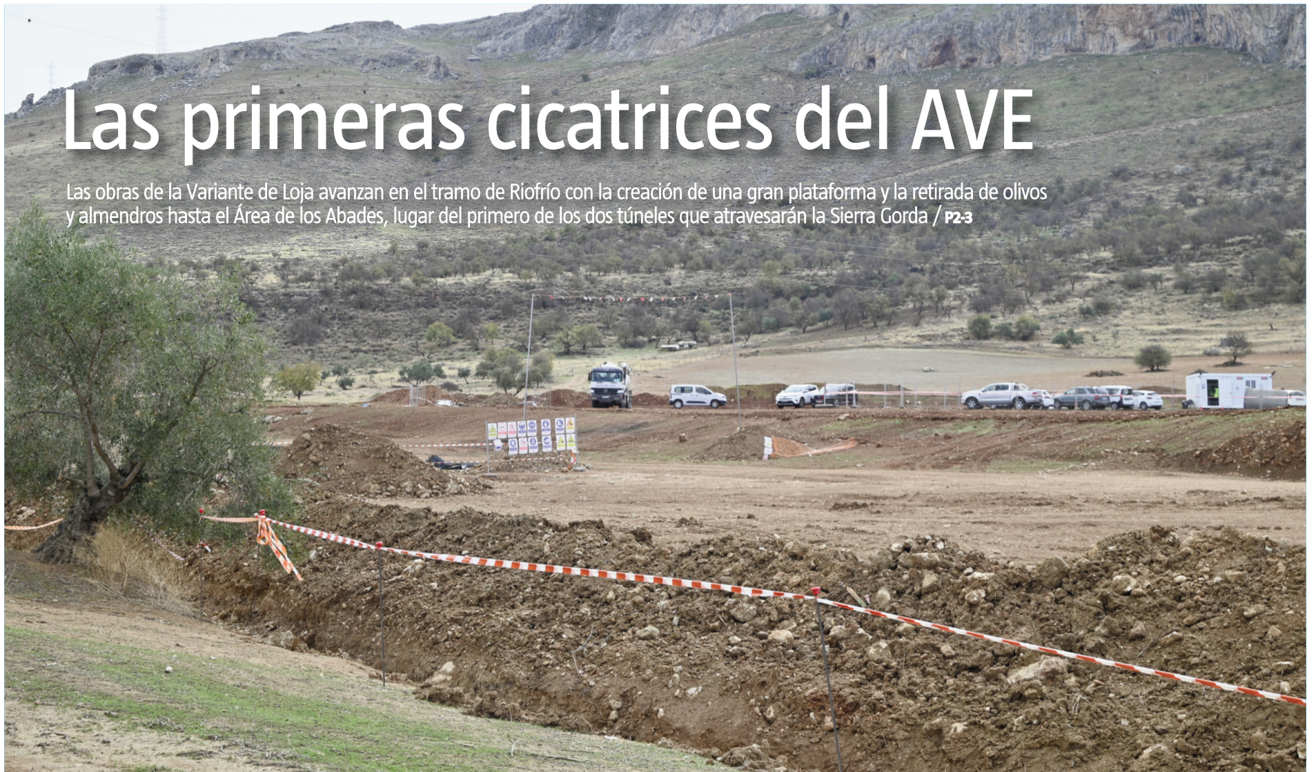
Zona de almacenaje y puestos de operarios de los trabajos del AVE en los últimos metros del tramo de Riofrío, justo antes de la creación del primer túnel de entrada a la Sierra Gorda de Loja. CARLOS MOLINA
