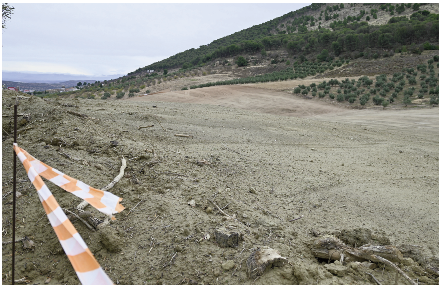
El trazado del AVE ya se vislumbra en su llegada a la falda de la Sierra Gorda de Loja a la altura del Área de Los Abades, donde se iniciará el primero de los dos túneles. CM
