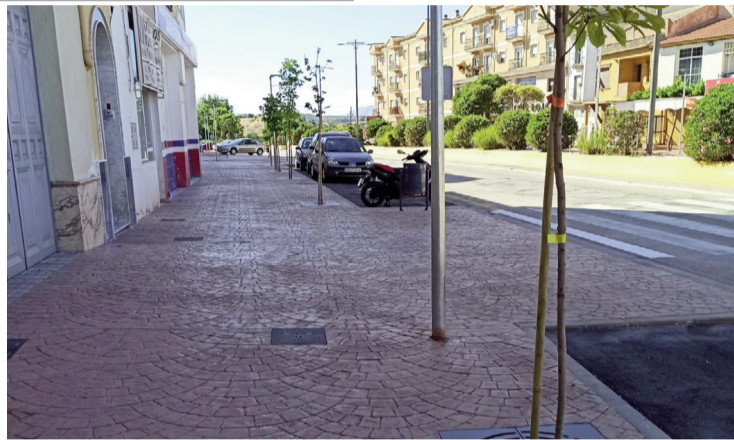
Vista general de la avenida de El Taxi con mejora en la accesibilidad. FOTO: C. MOLINA
